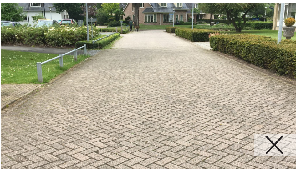
Foto 3: Weg als stoep gebruikt
